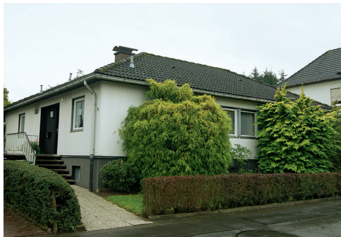
Abb. 1: Typisches Fertighaus der 70er Jahre.
